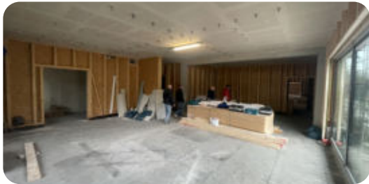
Multifunktionsraum mit Küchendurchgang
